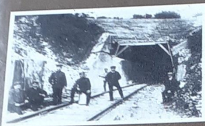
Tunnel (sud- zuid- südlich) 17.8.1914
