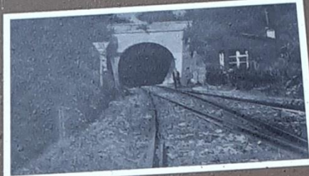
Tunnel (Nord. nördlich) 1895-1941
