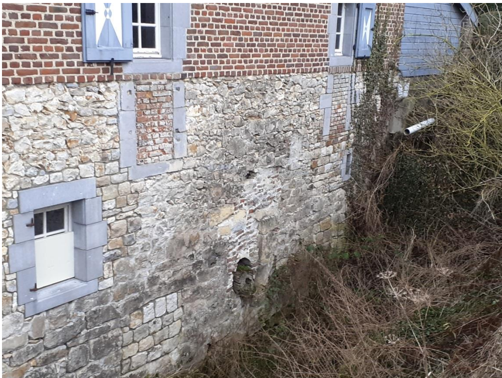
Er was eens een watermolen. Deze is er niet meer, maar het gebouw staat er nog mooi bij. Let op de verschillende soorten materialen waarmee dit gebouw is opgetrokken.
