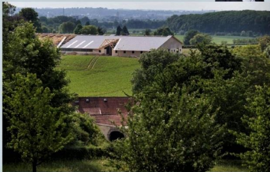
De omstreken paardenhouderij in aanbouw, gezien vanaf de Bemelerberg. FOTO: RUDOLPH WITTEL
