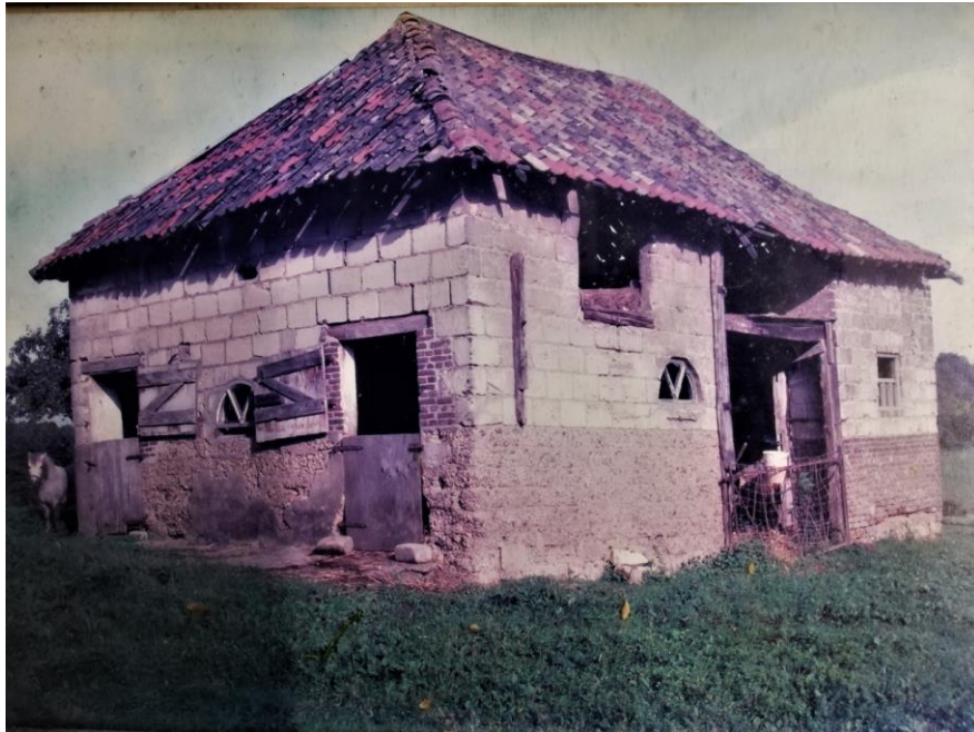
Veldschuur vlak voor de totale ineenstorting.
